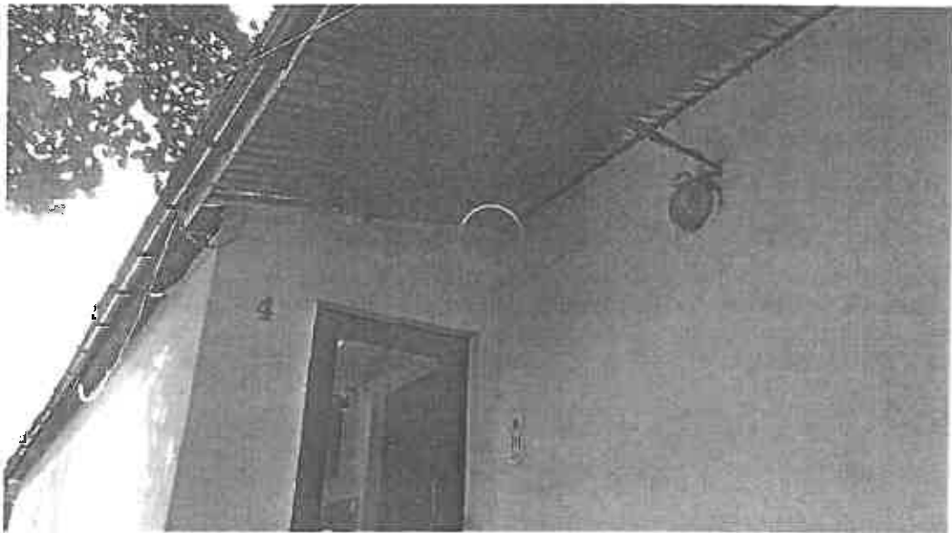
Fot. 12. Elewacja wschodnia budynku przy ul. Skrzatów 4 w Krakowie – otwory w miejscach połączenia ściany i daszku – fot. Tomasz Wieczorek.
