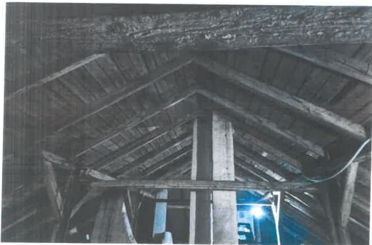
Foto – konstrukcja dachu.
