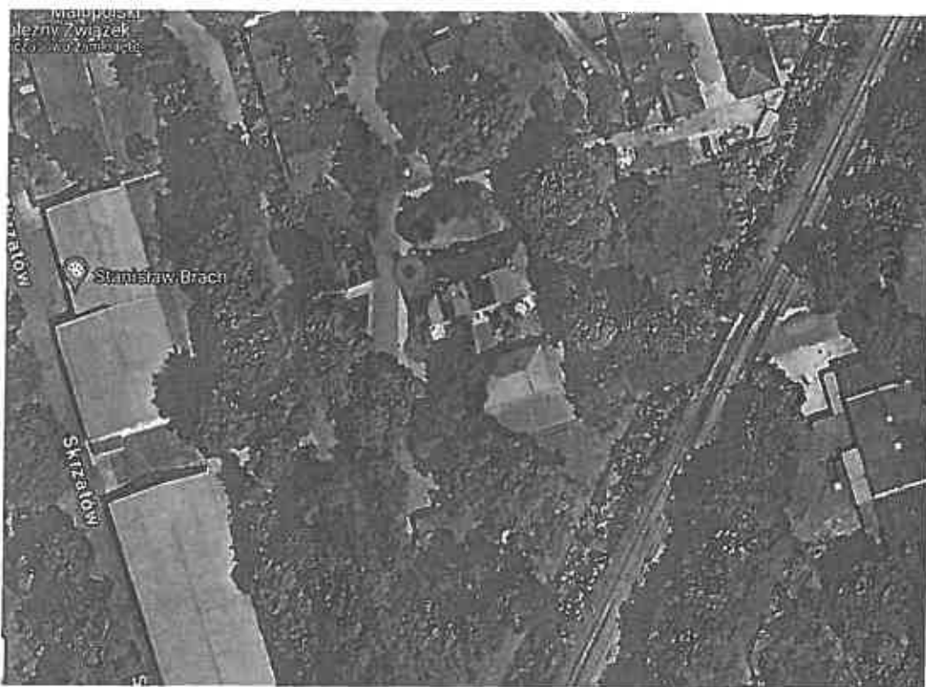
Fot. 1. Budynek przy ul. Skrzatów 4 w Krakowie – źródło Google maps
