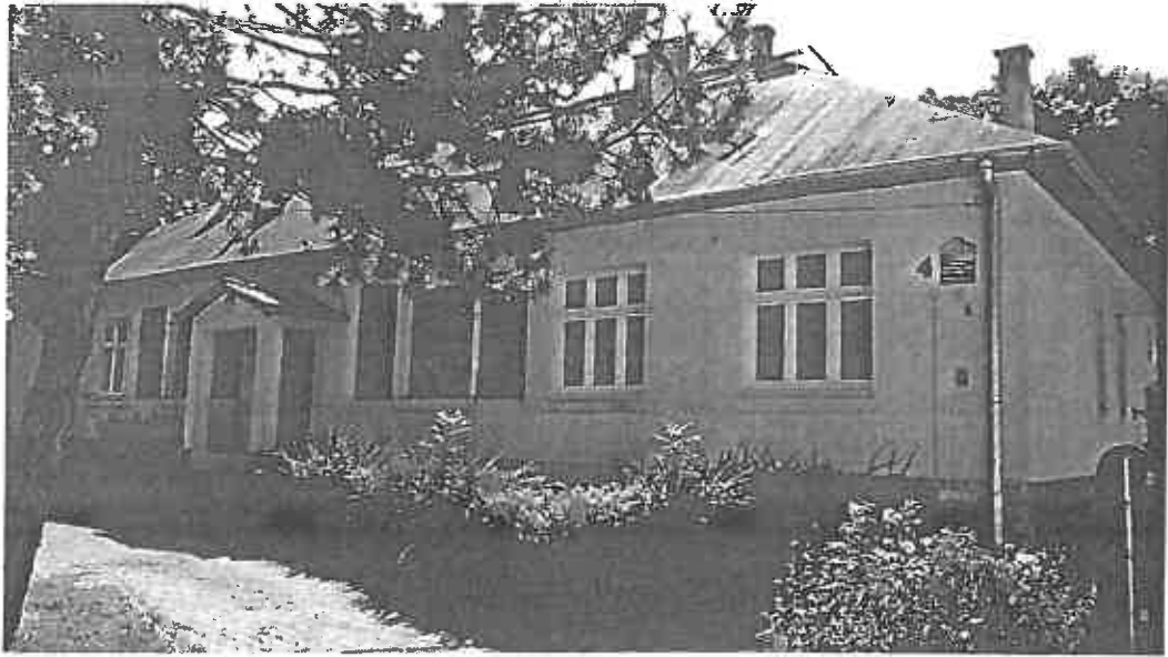
Fot. 3. Elewacja północna budynku przy ul. Skrzatów 4 w Krakowie – fot. Tomasz Wieczorek.
